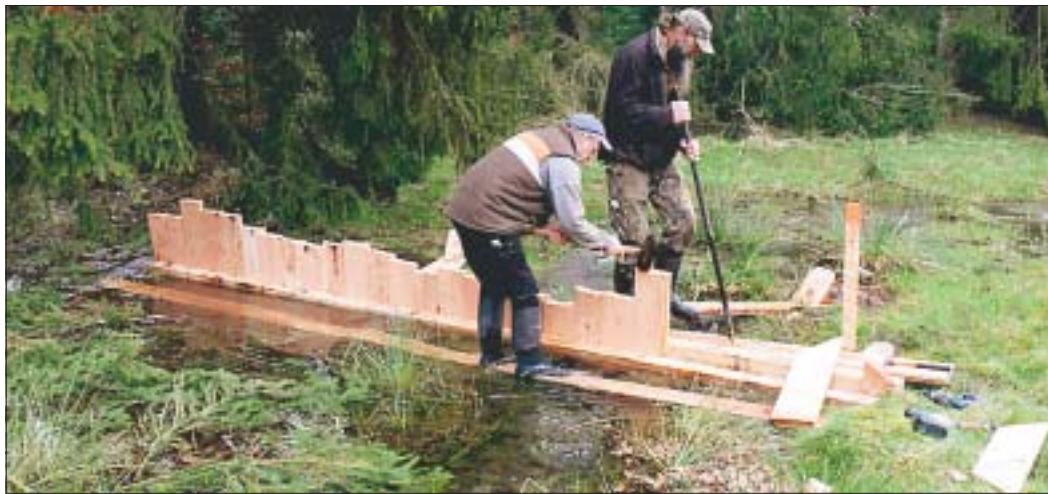
Mitarbeiter der niedersächsischen Landesforsten bauen im Solling ein Bauwerk aus Lärchenholz in einen Bachlauf, das das Wasser in den Wald leiten soll. BILD: DPA
